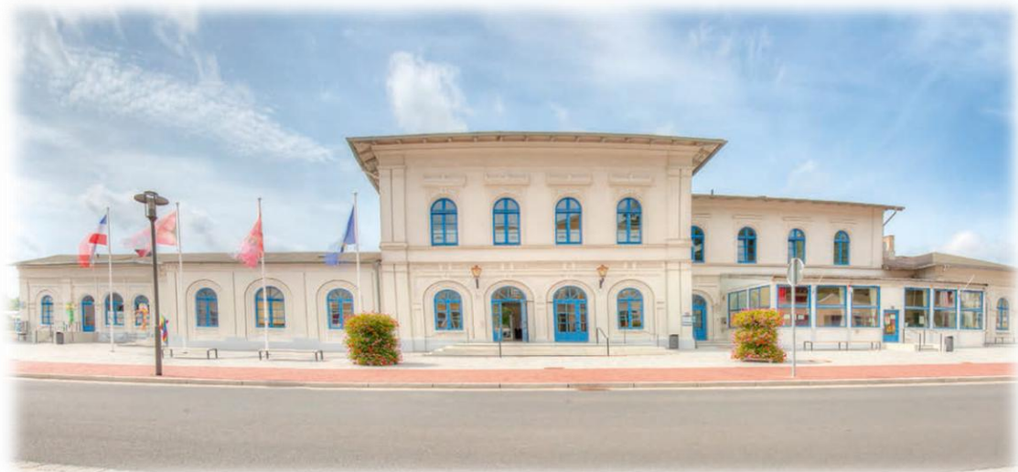
Abb. 30 Bahnhofsgebäude – Stadt Eutin Foto Stadt Eutin
